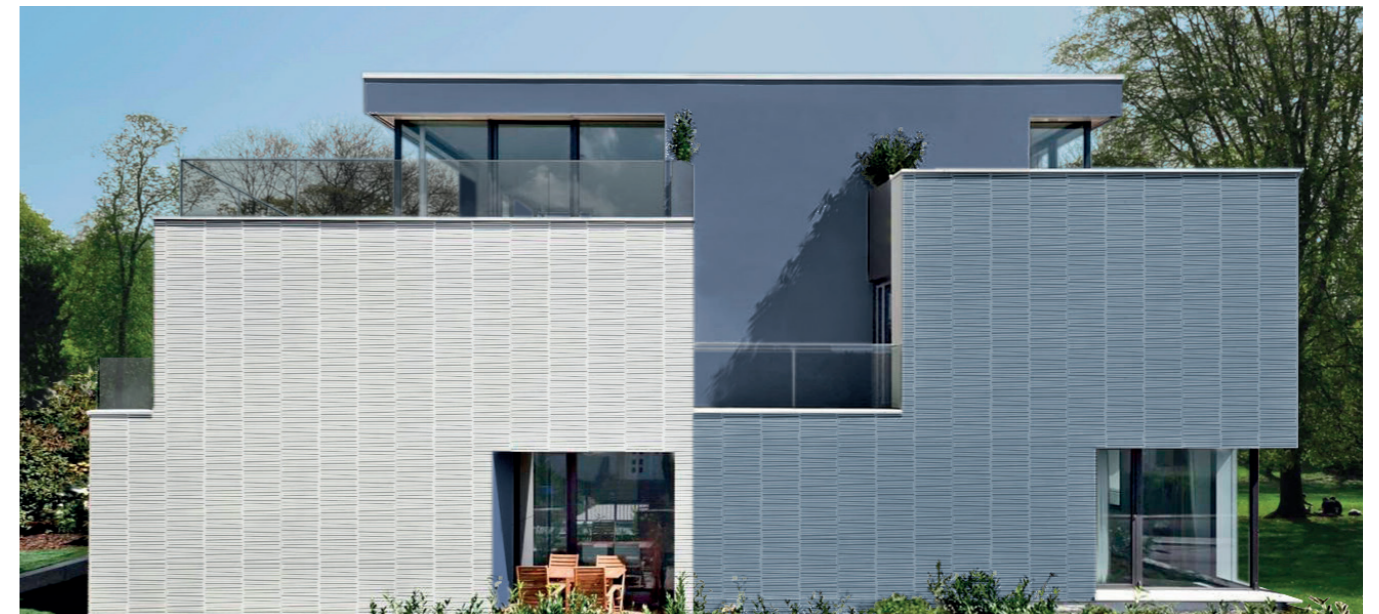
Structure 3 - Weber Empilement
